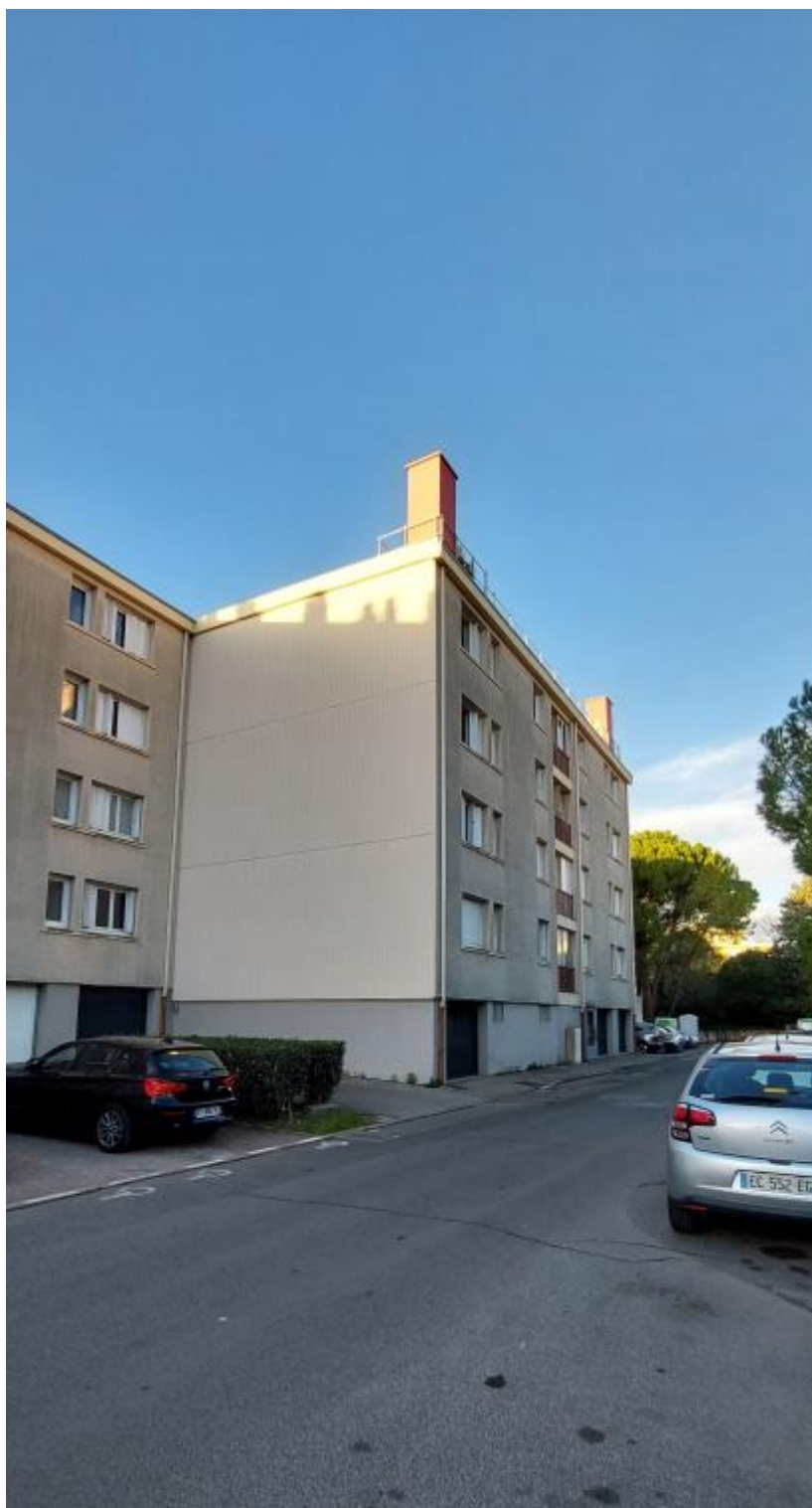
Vue 1 : Avant travaux
