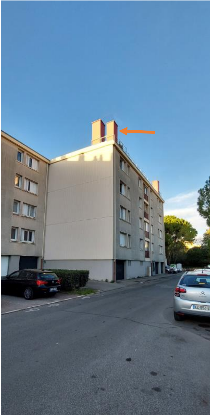
Vue 1 : Après travaux
